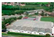
Учебный центр, производство лучистых теплообменников Training center, production of radiant heat exchangers Via Sile, 17
