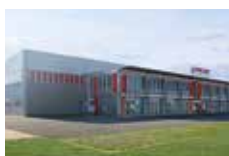
Головной офис, R&D исследования и разработки, производство горелок и лучистых потолков Headquarters, R&D, production of burners and radiant ceilings Via Sile, 48
